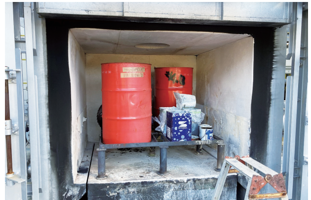
図 9 処理材を積載し、装入した炉内状況 （注：図 8 の運転チャートの処理材とは異なる）
