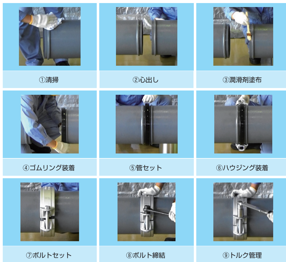
図2 継手接合手順
