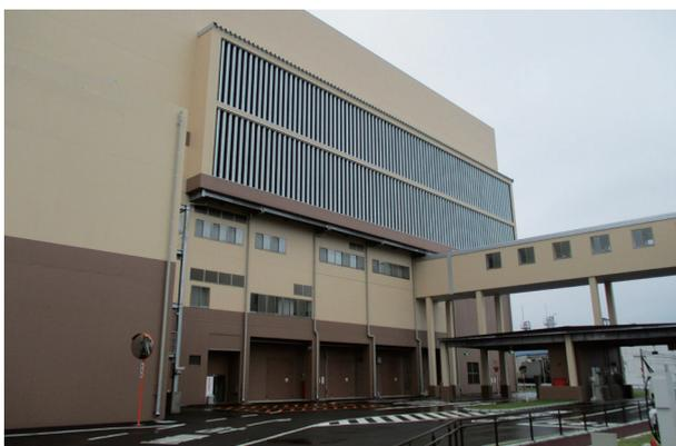
図8 対策事例(吸気消音器)
