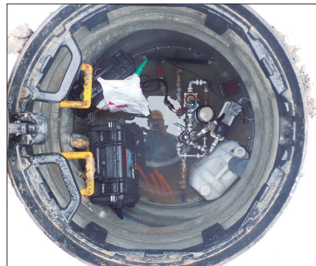
図10 下水道用1号マンホール内への装置設置状況(地点C)
