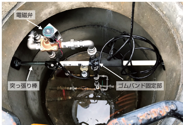
図 16 電磁弁位置立ち上げ案 試験状況
