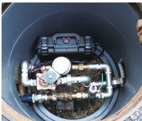
図3 φ500弁室内への設置例
