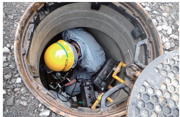
図23 人孔内での作業状況 左：大型量水器ボックス 右：下水道用1号マンホール
