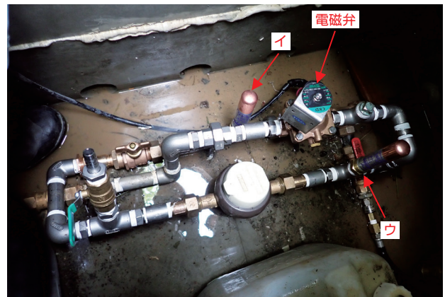
図21 水撃防止器試験用配管（左：配管イメージと設置場所、右：試験状況の例）
