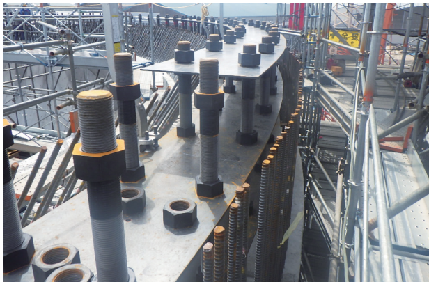
図 13 アンカーフレーム据付
