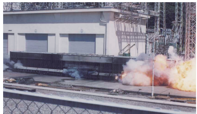
図2 地絡試験の状況
