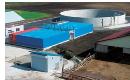
バイオガスプラント
