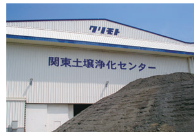
関東土壌浄化センター
