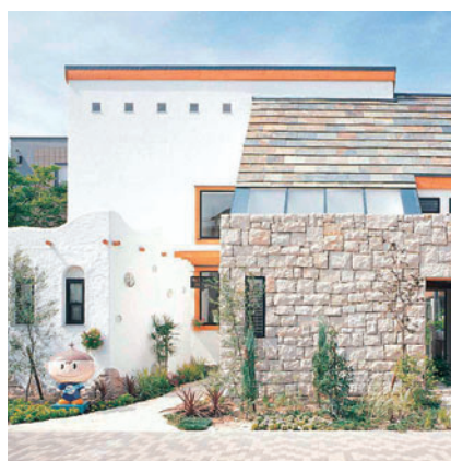
漆喰塗り仕上げに一部鎮石とジュラシックウッドストーンを配した外壁。粘板岩を使った石葺きのカラフルな屋根。天然素材の持つ温もりのある外観です。
