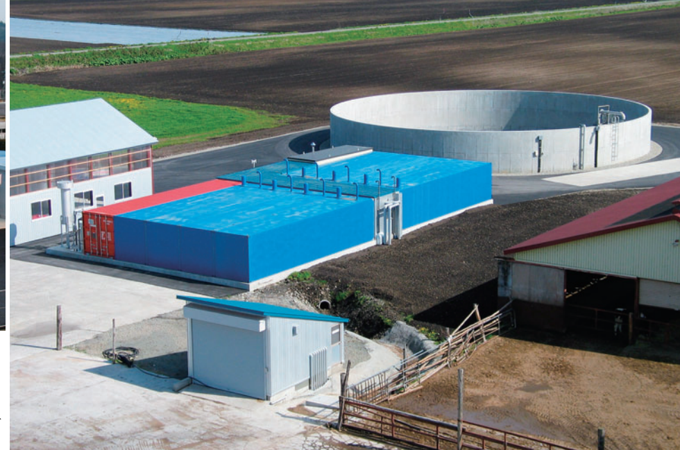
バイオガスプラント全景。青い建物がコンテナ型のモジュール式発酵槽。
