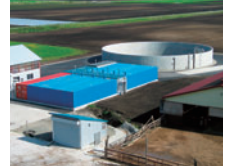
バイオガスプラント
