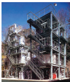
ガス化溶融炉
