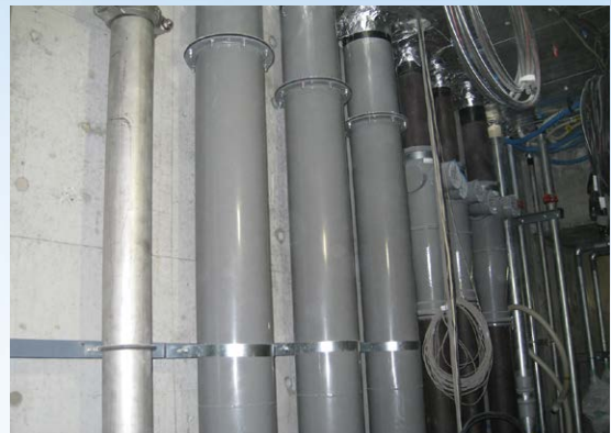
臭突管施工例
