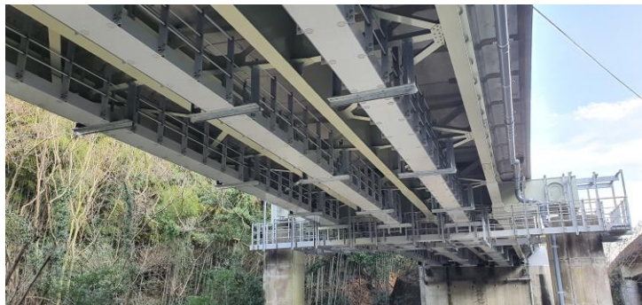
関門自動車道 山中高架橋
